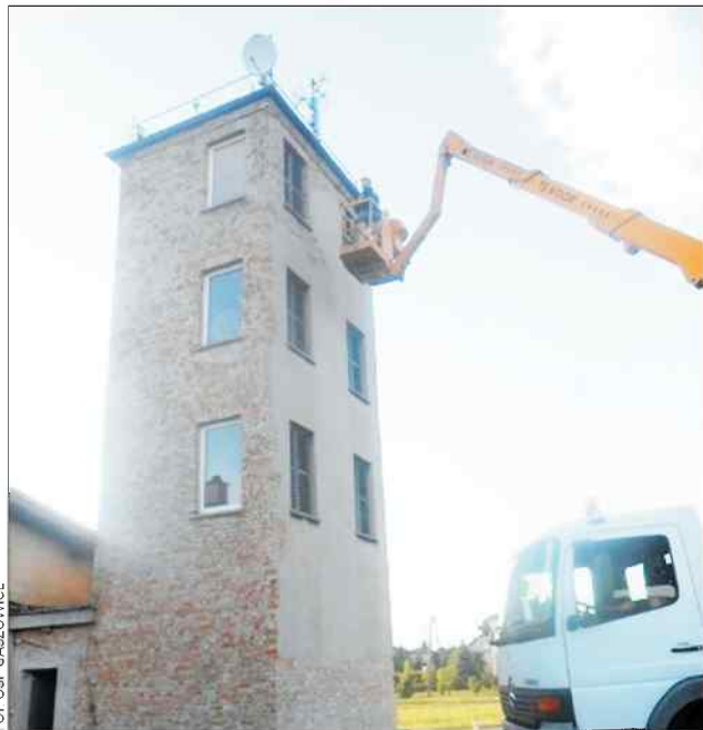
Jednym z elementów remontu było skucie starej elewacji wieży
