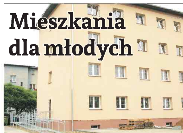
Wyremontowany budynek przy ul. Zebrzydowskiej czeka na mieszkańców
