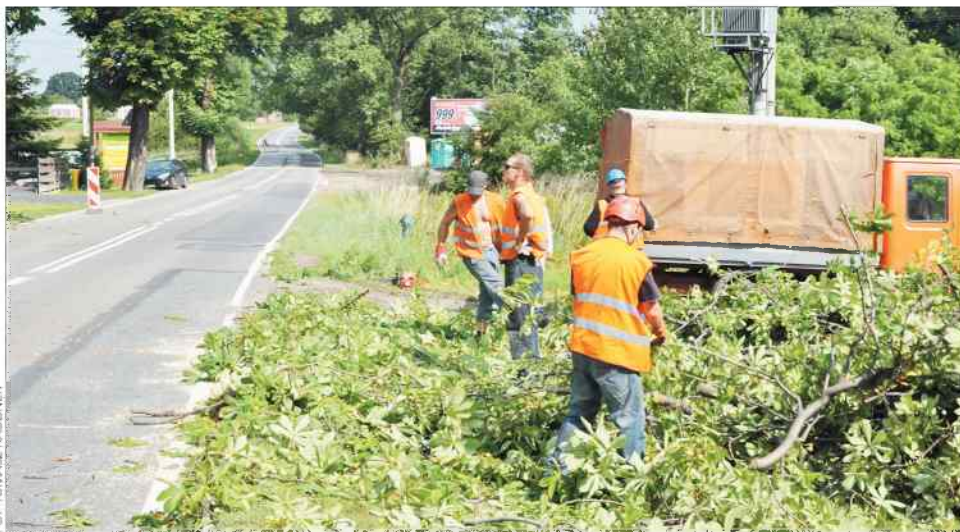
Ruszyły prace przy ul. Rudzkiej. Ruch na tej ulicy będzie się odbywał wahadłowo.
