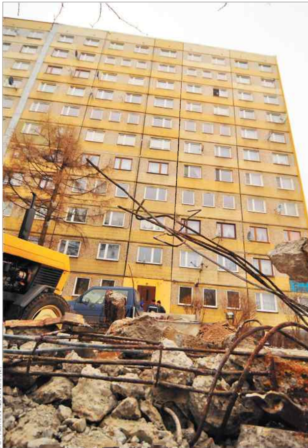
Przed blokiem na ulicy Chabrowej trwa intensywny remont wejścia do bloku
