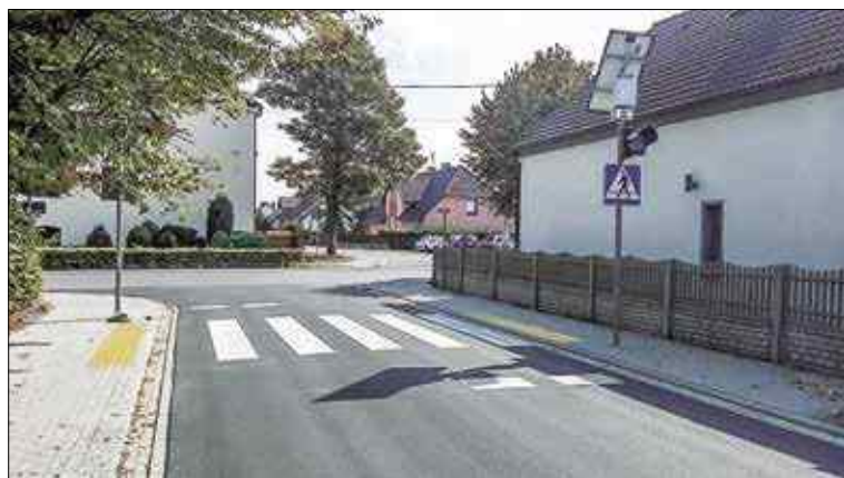
Sygnalizacja świetlna w tym miejscu dziwi, ale bez niej mogłoby nie być remontu całej drogi
