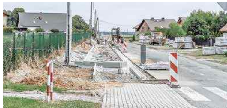
Trwa budowa w Zimnej Wódce
