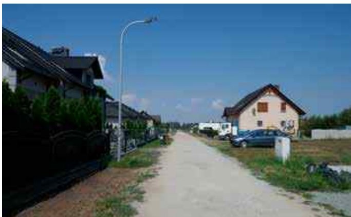
Budowa oświetlenia na ulicy Cichej w Bierawie
