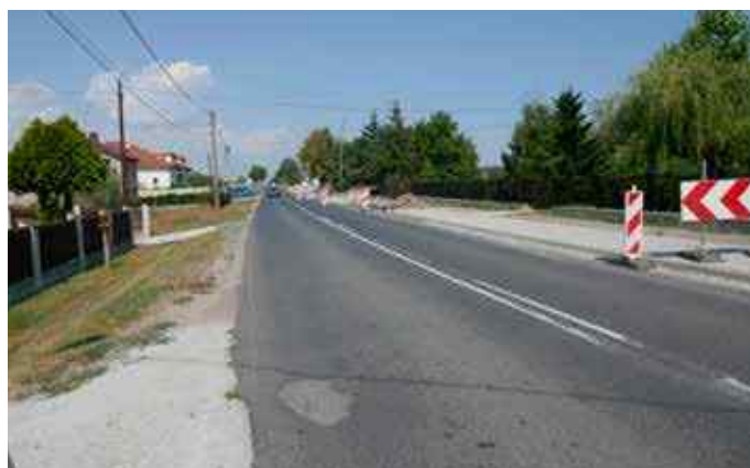
Budowa chodnika w Dziergowicach, ul. Kozielska
