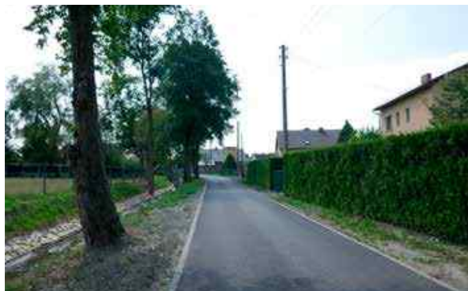
Przebudowa ulicy Wiejskiej w Goszycach
