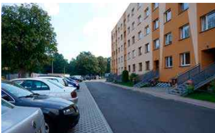
Przebudowa ulicy Gliwickiej 15 w Kotlarni
