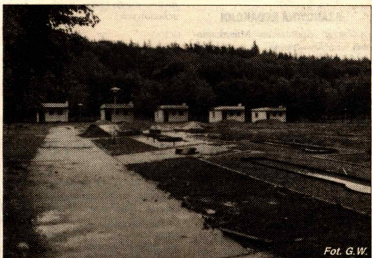
Budowa basenów to szansa na ożywienie kempingu w Oborze
