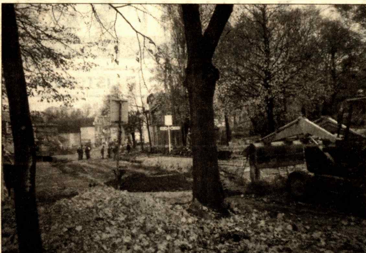
Trwają prace związane z budową kanalizacji sanitarnej
