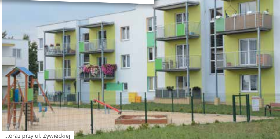
...oraz przy ul. Żywieckiej
