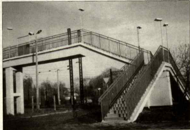
Solidna kładka będzie służyć mieszkańcom
