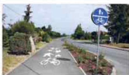
Budowa i przebudowa chodników
