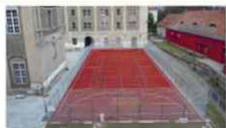
Budowa boisk wielofunkcyjnych wraz z infrastrukturą
