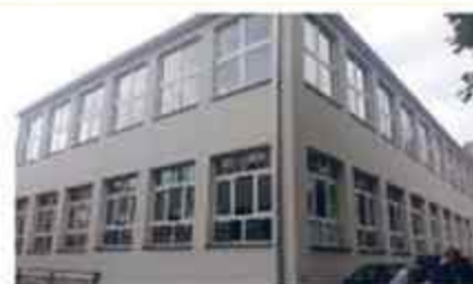
Termomodernizacja obiektów oświatowych
