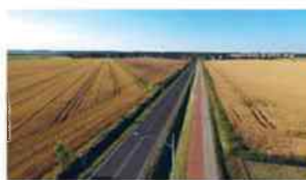
Budowa i przebudowa dróg
