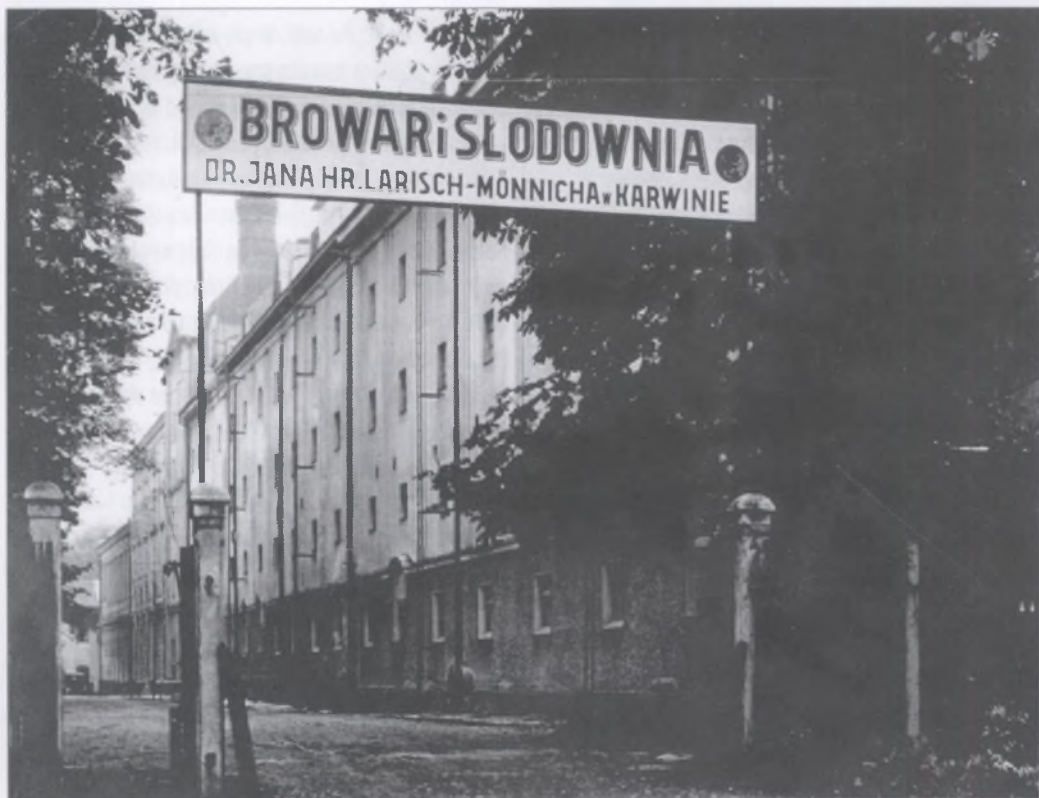
Budynek Browaru i Słodowni hrabiego Larischa
