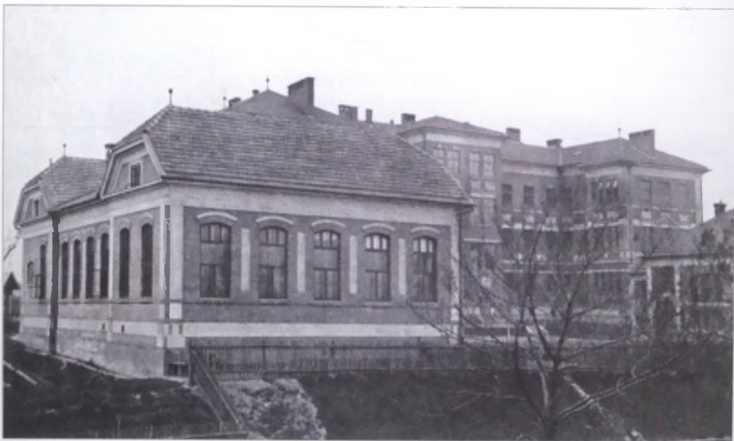
Budynek polskiej szkoły (na pierwszym planie), za nim (większy budynek) to szkoła niemiecka (1910) a po 1918 roku czeska (Archiv Vitkovice, a. s.)
