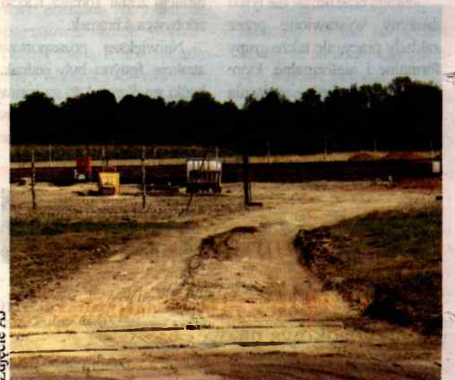
Przy ulicy Poznańskiej budowane są bloki wielorodzinne - łącznie 30 mieszkań.
