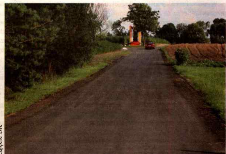
Przebudowana droga w niczym nie przypomina dziurawej i błotnistej szutrowki, która była w tym miejscu jeszcze kilka miesięcy temu.
