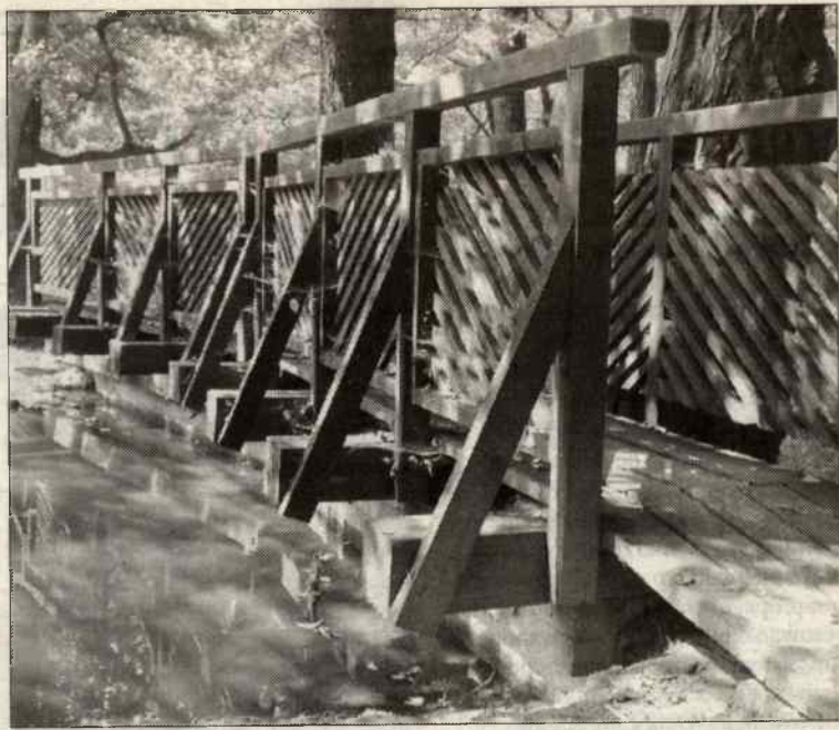
Dla ułatwienia spacerów wykonano mostki i ścieżki
