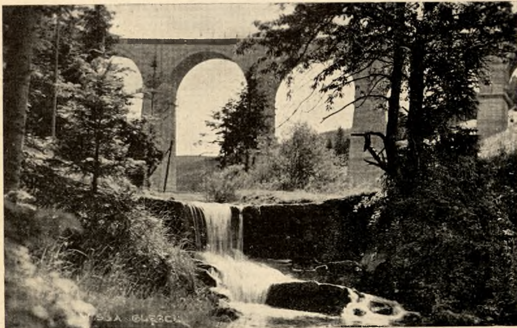
Wisła-Głębcz: Wiadukt kolejowy nad Dol. Łabajową.
