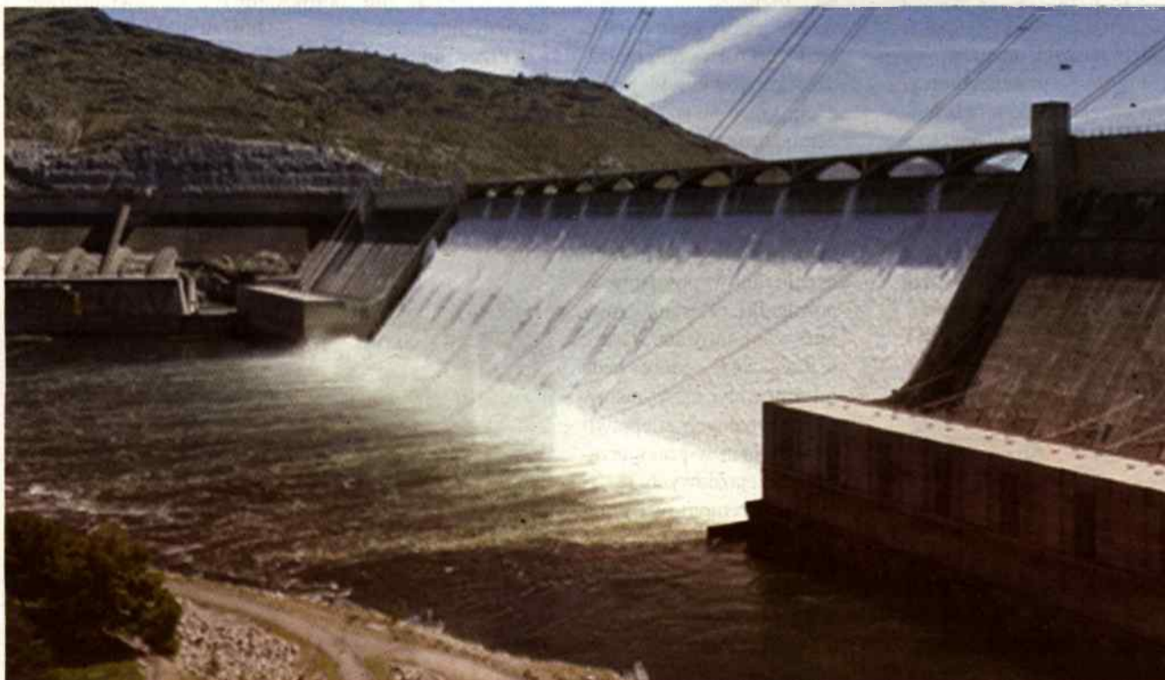
Wykorzystanie w elektrowniach energii wodnej polega na spiętrzeniu, a następnie przetworzeniu energii spadających wód w energię mechaniczną lub elektryczną.
