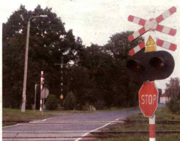
Prawie dwa miesiące ma potrwać remont przejazdu kolejowego.
