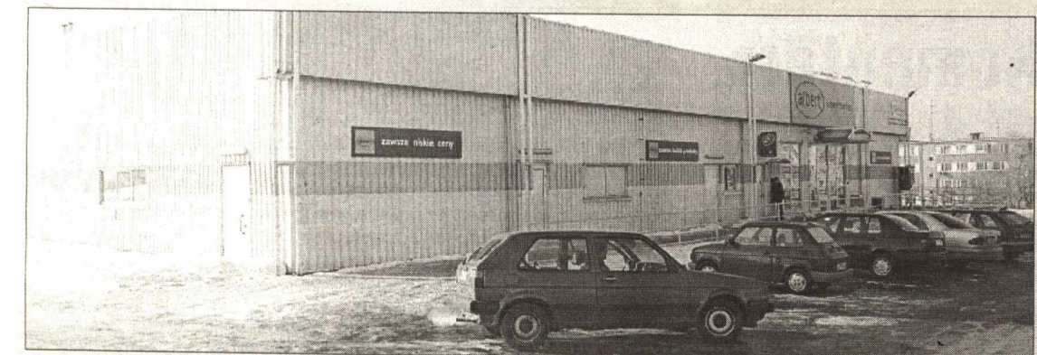
Po tragedii w Katowicach wiele osób z obawą spogląda na dachy wielkopowierzchniowych budynków z płaskimi lub lekko pochylonymi dachami. W powiecie prudnickim dużych budynków o lekkiej konstrukcji najwięcej jest w stolicy. Są to markety: Lidl, Kaufland (w budowie), Albert i Merkury.
