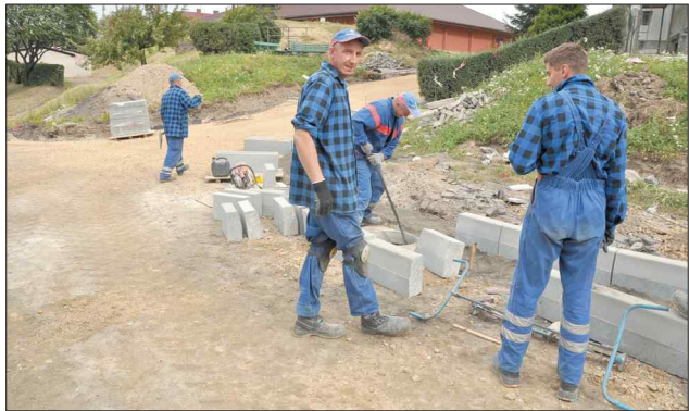
Trwa układanie chodników, droga ma już pełny podkład, rozpoczęło się wylewanie asfaltu
