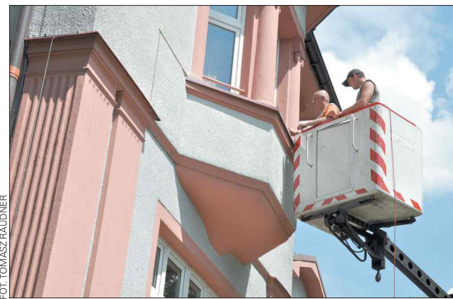
Ekipa rozpoczęła już montaż oświetlenia
