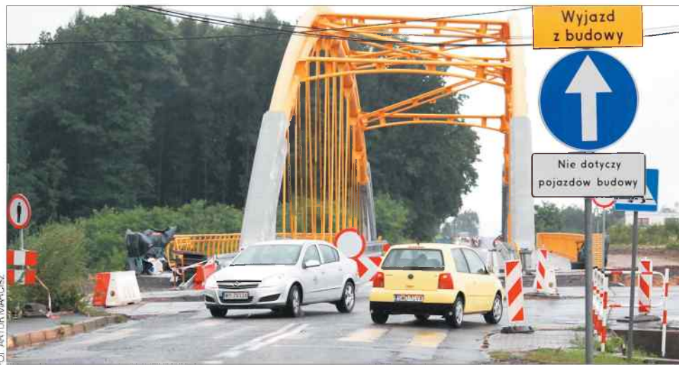
Most na ulicy 1 Maja w Skrzyszowie jest już prawie gotowy. Czeka na odbiór techniczny.
