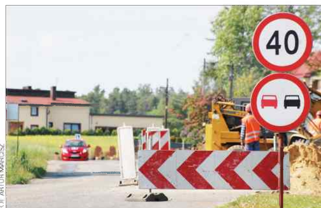
Kierowcy powinni uważać na pewne utrudnienia związane z budową kanalizacji deszczowej
