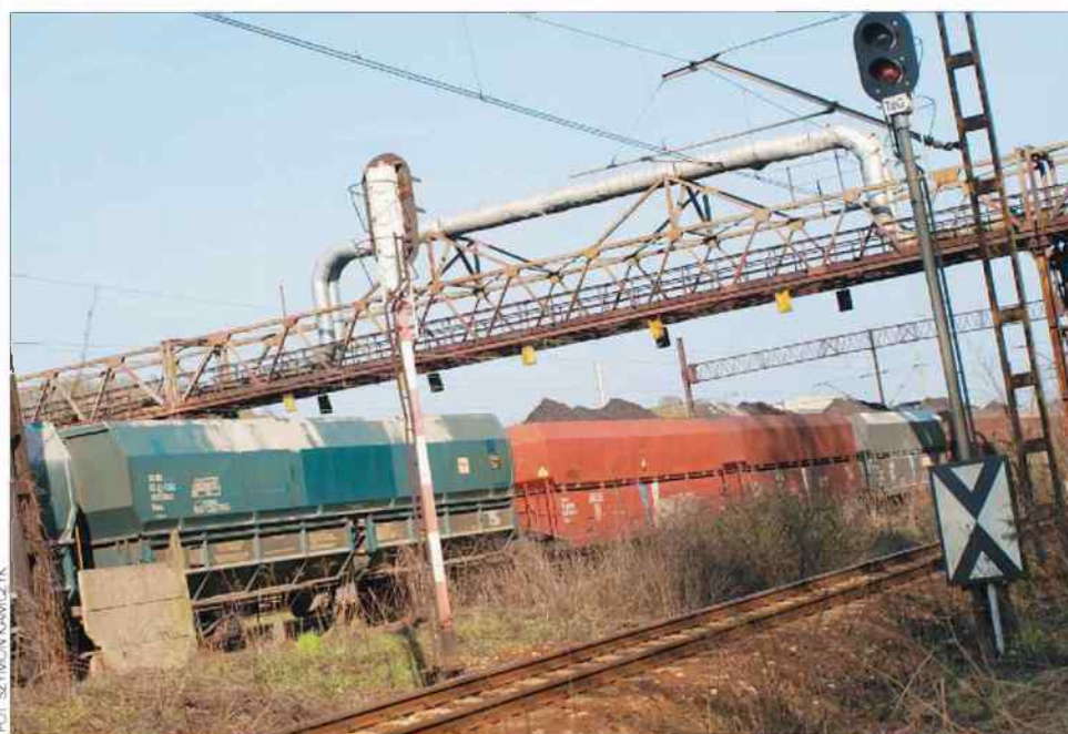
Torowisko w rejonie ul. Kościuszki nie jest odpowiednio zabezpieczone. Mur oddzielający wagony jest w wielu miejscach zburzony, a strażników brak.
