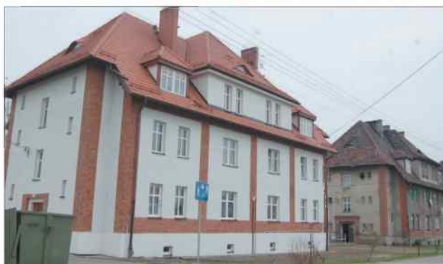
Wyremontowany pod koniec ubiegłego roku budynek przy Leśnej 1 zmienił się nie do poznania. W tym roku rozpocznie się remont budynku obok.
