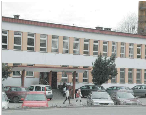
Budynek sądu w Wodzisławiu
