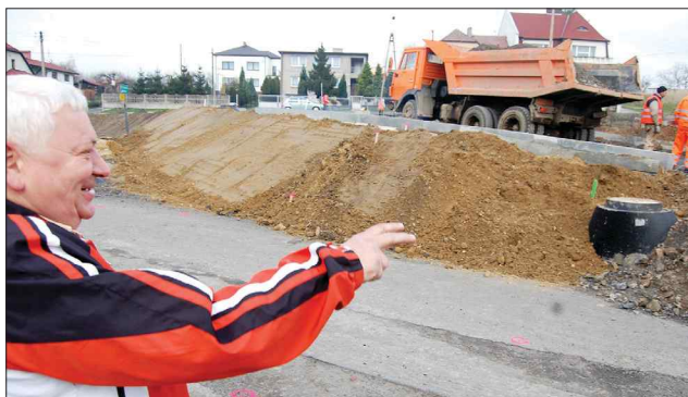
Ryszard Grzegoszczyk uważa, że od strony OPS-u trudno będzie kierowcom włączyć się do ruchu na przebudowanym skrzyżowaniu
