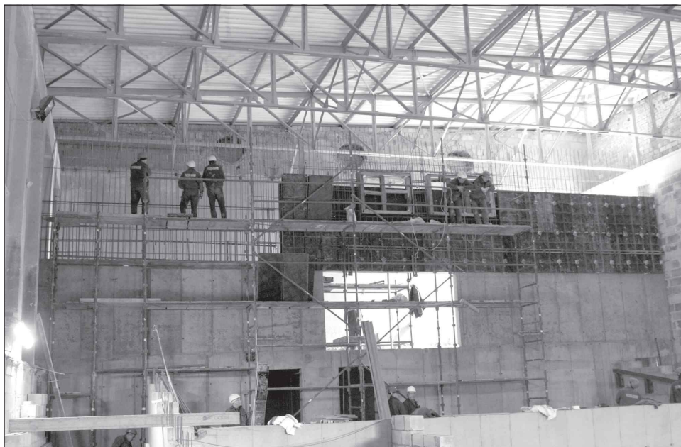
Jednym z elementów termomodernizacji będzie nowy, docieplony dach
