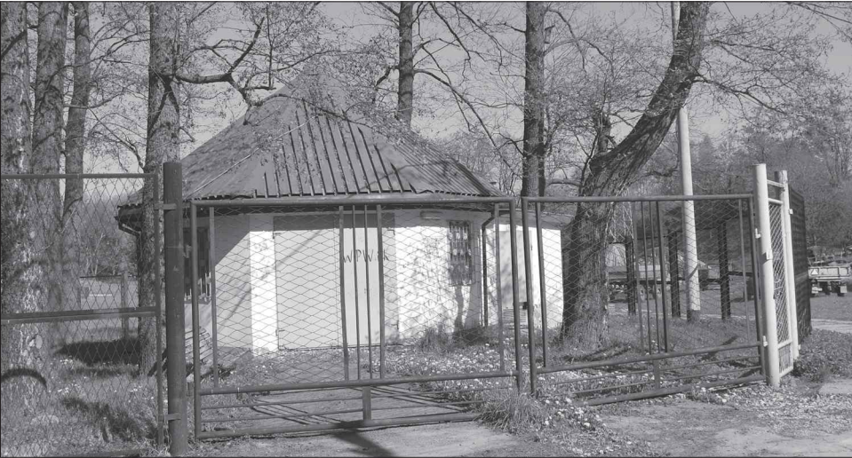
Pod niewielkim budynkiem znajduje się zbiornik wody spływającej z sześciu studni
