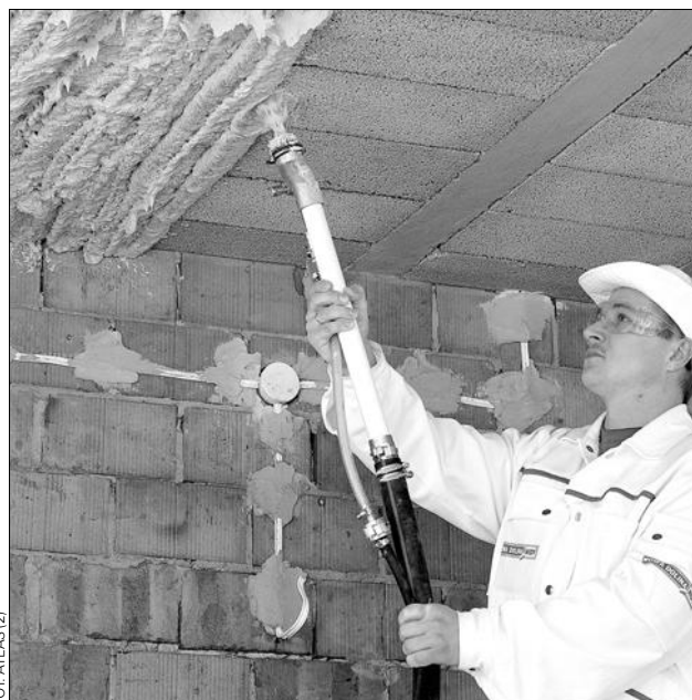
Nakładanie tynku przy użyciu pistoletu natryskowego
