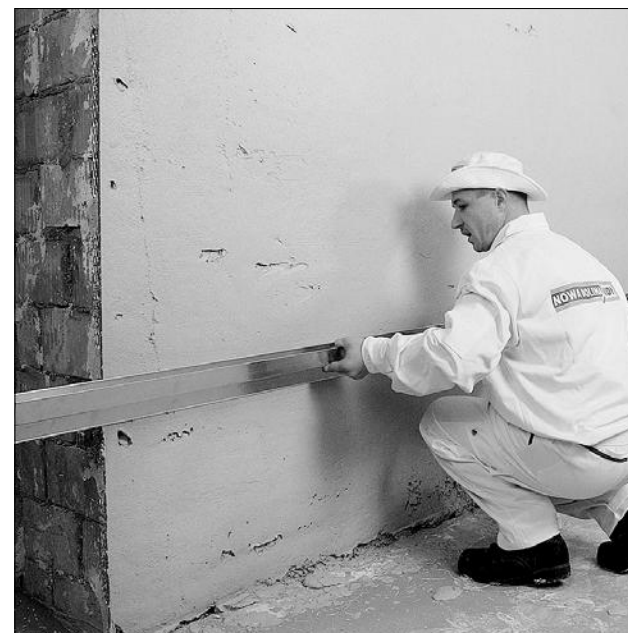
Wyrównywanie powierzchni tynku łatą H
