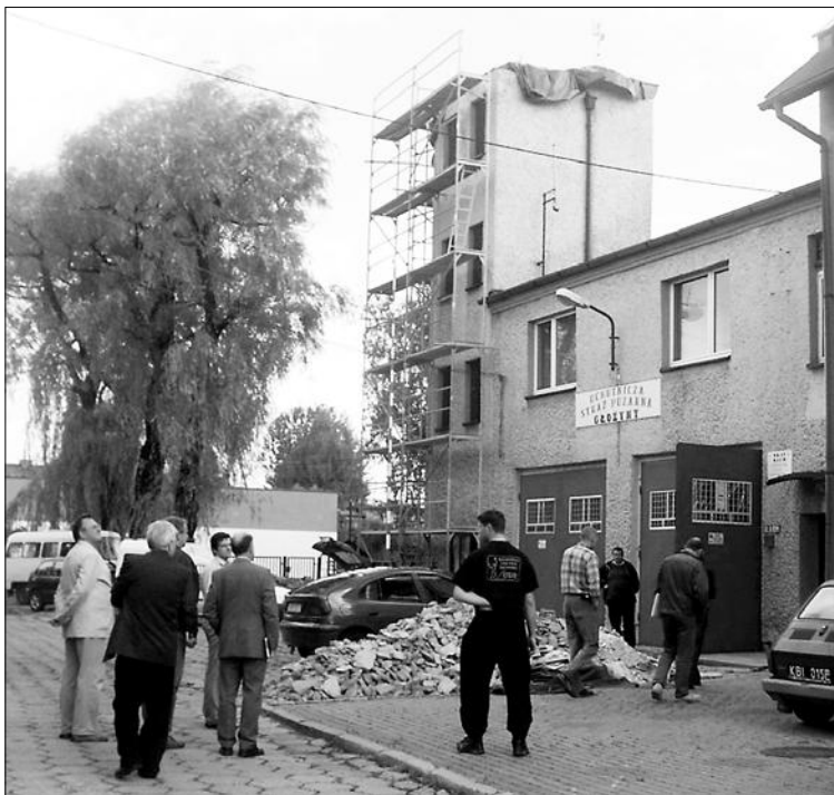
Remont remizy przebiegał bardzo sprawnie
