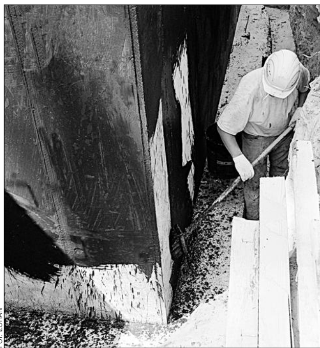
Nanoszenie masy bitumicznej
