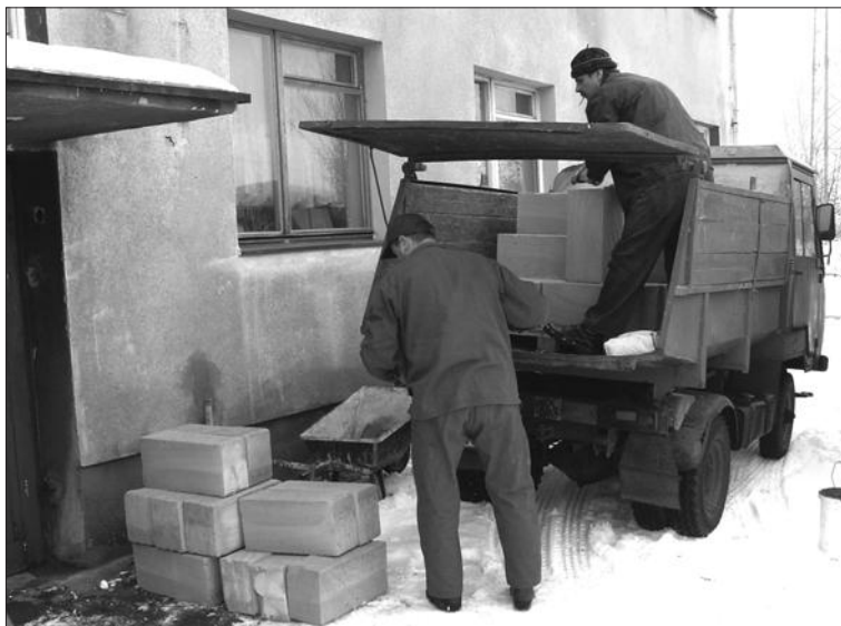
Pierwszego grudnia przed południem ekipa budowlana zamurowała wejście
