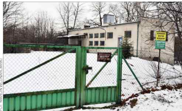
Oczyszczalnia w Rudach, do tej pory pracowała dla stu osób. Po modernizacji ma zwiększyć wydajność 14-krotnie.
