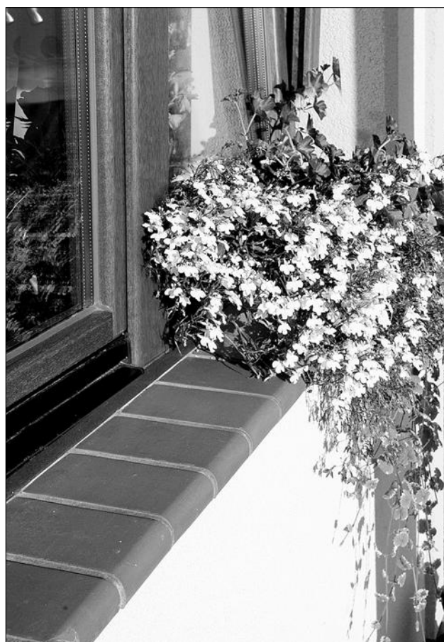
Klinkierowe parapety zdobią okna
