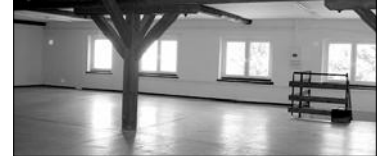
RACIBÓRZ - lokal magazynowo-handlowy na lp. w centrum. Pow 200 m 2 , odnowiony. Pom halowe, wc-socjal, pom biurowe. Nowe okna i drzwi PCV, Ciekawe wnętrza. CZYN SZ - 1500 zł /mies.+ VAT.
