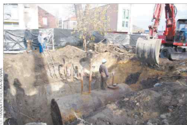
W piątek robotnicy odkopali zbiorniki, a w sobotę wydobyli je na powierzchnię
