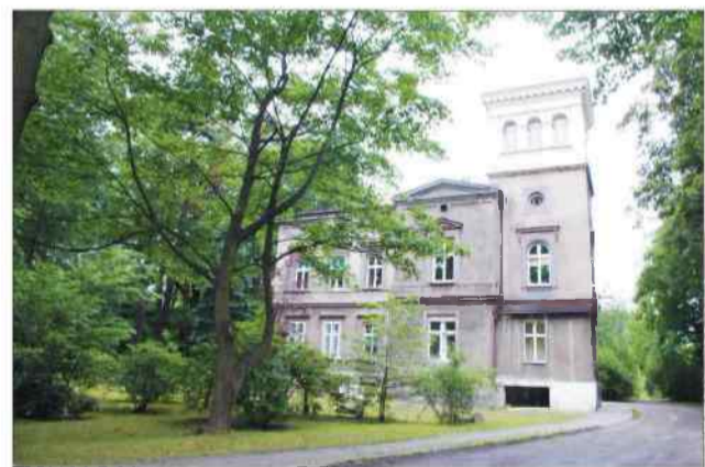
Remont instalacji ogrzewania w zameczku jest już gotowy, ale trzeba czekać aż PEC podłączy to wszystko do sieci
