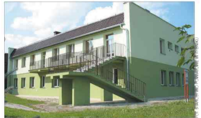
Jednym ze zmodernizowanych budynków jest Przedszkole w Czernicy
