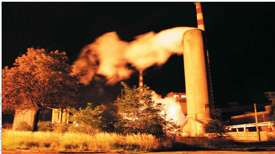
Koksownia Dębieńsko planuje przeprowadzenie remontu baterii przez co działalność zakładu stanie się mniej uciążliwa dla mieszkańców
