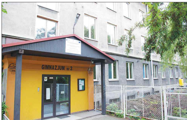
W Gimnazjum nr 2 w Leszczynach już widać postępy w termomodernizacji.
