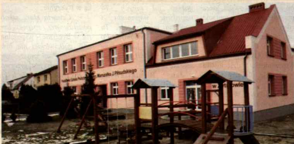
Teraz przeszedł on kompleksowy remont, który kosztował ponad półtora miliona złotych.
