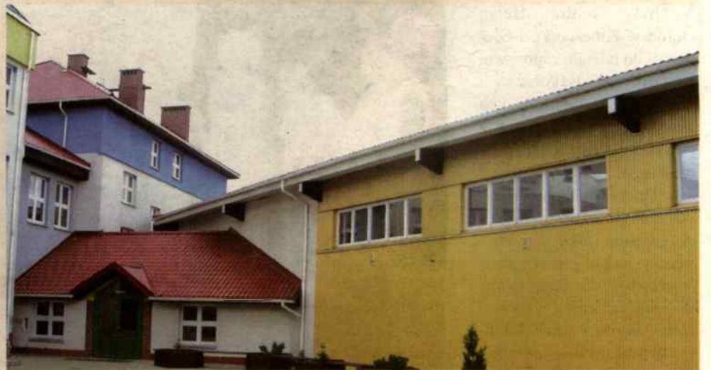
Nowoczesne gimnazjum w Byczynie, a przy nim hala gimnastyczna, która zaraz po otwarciu okazała się budowlanym buble.
