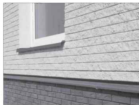
Cokół z obróbką blacharską
