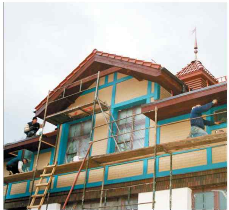
Mur pruski w wersji współczesnej. Technologia jego wykonania nie jest zbyt skomplikowana. Fot. ATLAS
