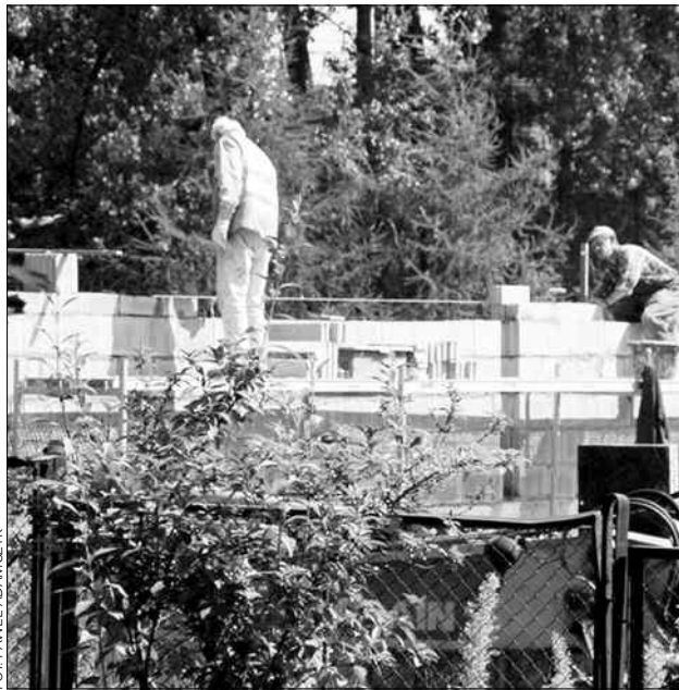
Trwa budowa nowego pawilonu dworcowego PKS-u
