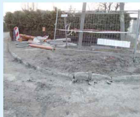
Prace budowlane utrudniają mieszkańcom życie, po ich zakończeniu ma być lepiej
