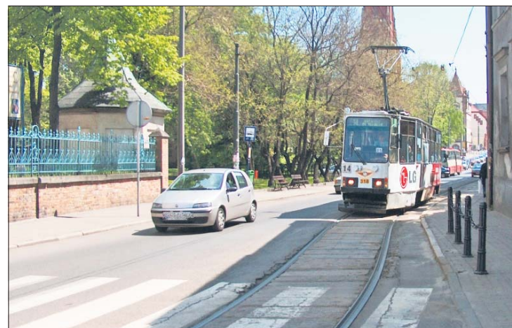
Modernizacja torowiska obejmie odcinek od ul. Bytomskiej do Powstańców
