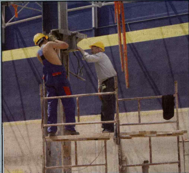
Ze starego budynku zostanie tylko stalowa konstrukcja.
