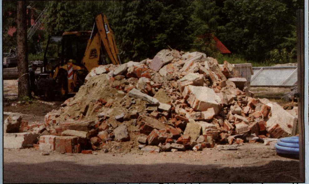
Teren wokół hali zmienił się w plac budowy. Tak będzie jeszcze do przyszłorocznej jesieni.
