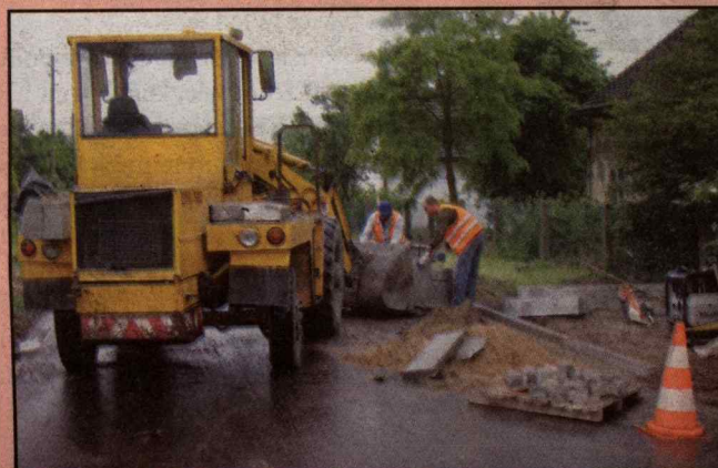
Prace przy budowie drogi trwają od kwietnia.
