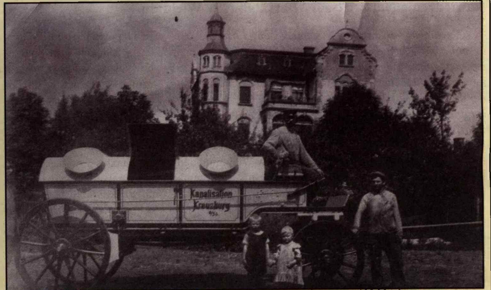
Ekipa zajmująca się konserwacją kanalizacji wyrusza do pracy (1911 r.).
