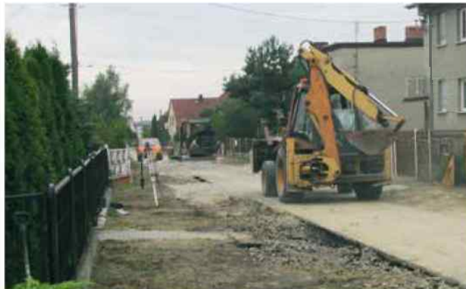
Inwestycje - Budowa kanalizacji sanitarnej w Dziergowicach
