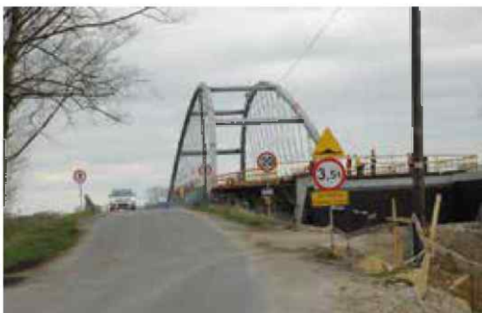
Budowa mostu Bierawa - Cisek
