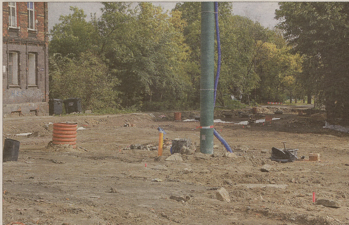
Nie wiadomo, kiedy zostaną wznowione roboty u zbiegu Świętochłowickiej i św. Piotra.
