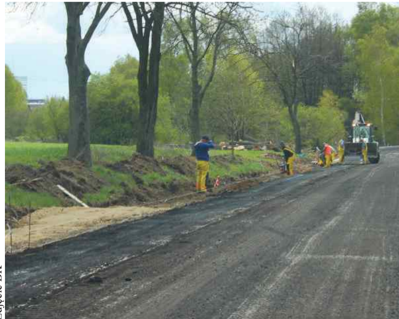
Na przebudowywanej drodze Praszka-Przedmość widać już postęp prac.
