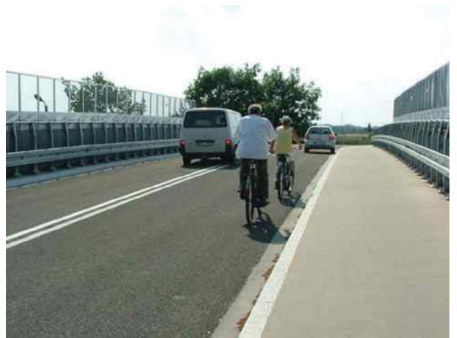
Jedna z trudniejszych inwestycji - remont wiaduktu w Kluczborku.
