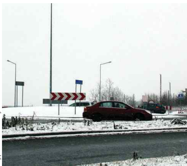
Czwarty odcinek zachodniej obwodnicy miasta poprowadzi od ronda w Ligocie Dolnej do Smard.
